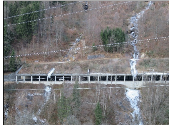
Bild 2: Zwischen Schwanden und Engi ist die Sernftalstrasse teilweise durch eine Galerie geschützt.
