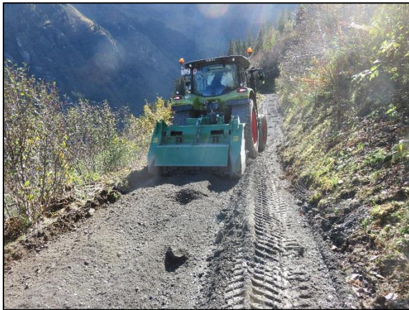
Bild 1: Einfräsen des vorgelegten Materials.
