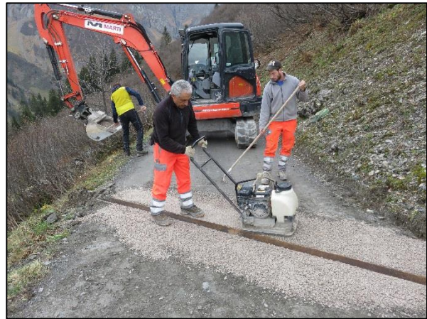
Bild 2: Einbau einer Querrinne aus Stahl.
